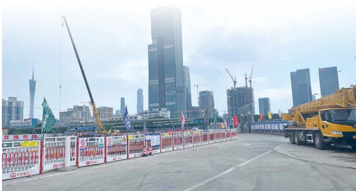
工地路面 100% 硬化
