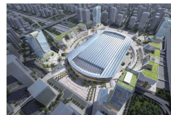
白云(棠溪)站西地块场站综合体项目
