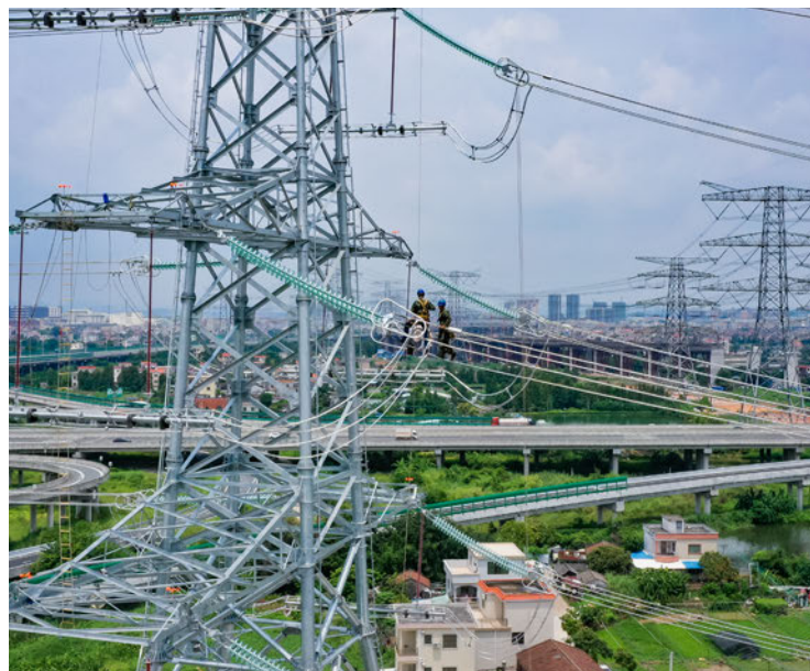
GIL创新技术在广州南沙港铁路建设中应用，克服了用电高峰期省内和澳门地区大面积停电的影响
