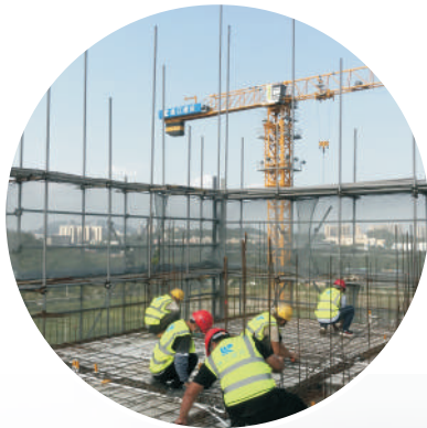
珠江建设在广氮项目采用装配式建筑工程技术
